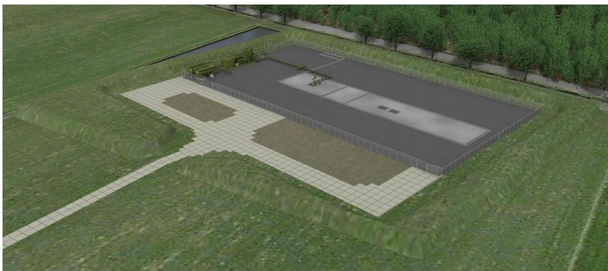
Figuur 22. Visualisatie van een mijnbouwlocatie met toegangsweg, omwalling, watergang, terreinverharding en gaswininstallatie.
