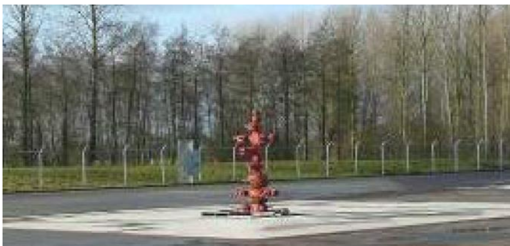
Figuur 25. Voorbeeld van een spuitkruis, mijnbouwlocatie De Hoeve.
